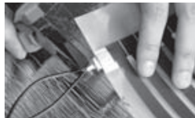
Рис. 12. Надежно зажмите провода в контактном зажиме
