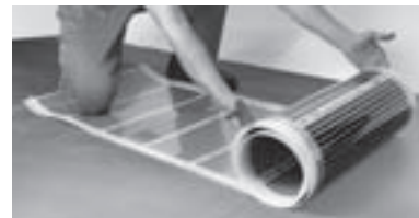
Рис. 3. Раскатывание рулона теплого пола на теплоотражающем материале
